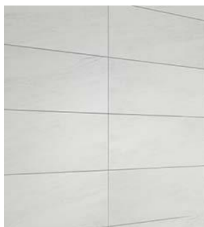
Figura 4-Cerâmicas das paredes
