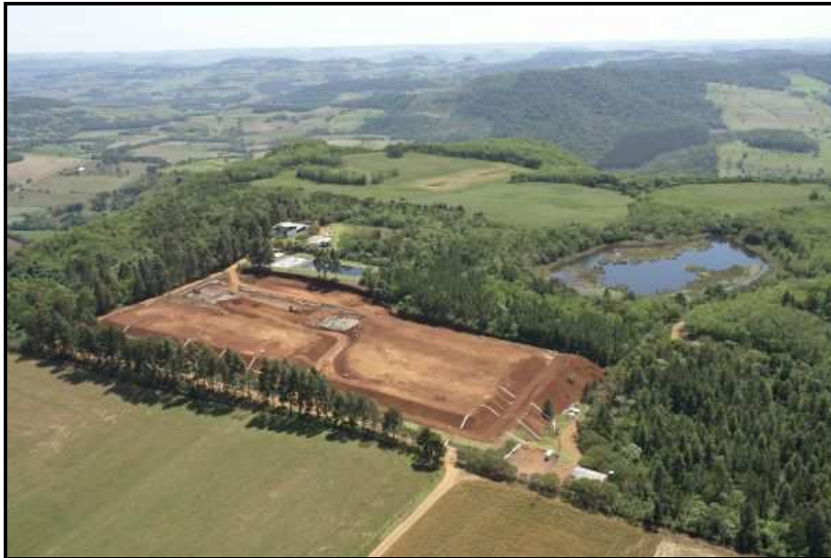
Figura 18: Aterro Sanitário da empresa TUCANO em Anchieta – SC
