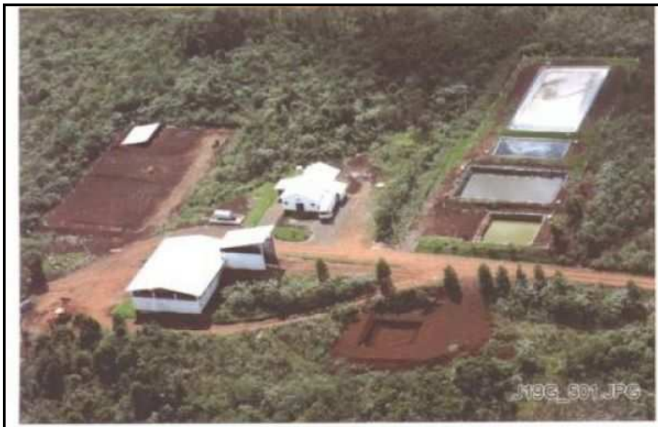
Figura 19: Aterro Sanitário da empresa TUCANO em Anchieta – SC
