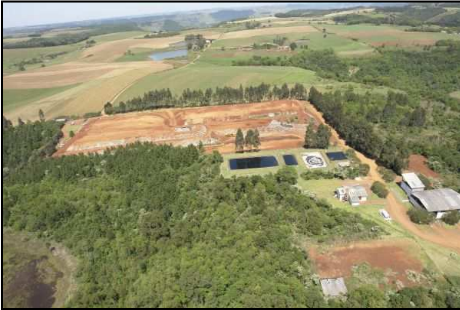
Figura 20: Aterro Sanitário da empresa TUCANO em Anchieta – SC
